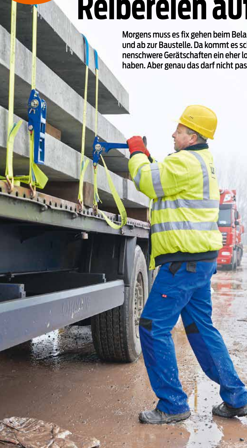
Niederzurren von Betonplatten, Zurr-Rechner
